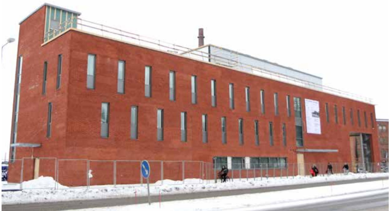
KUVA 26. VEBIC / KdY Energy Lab
