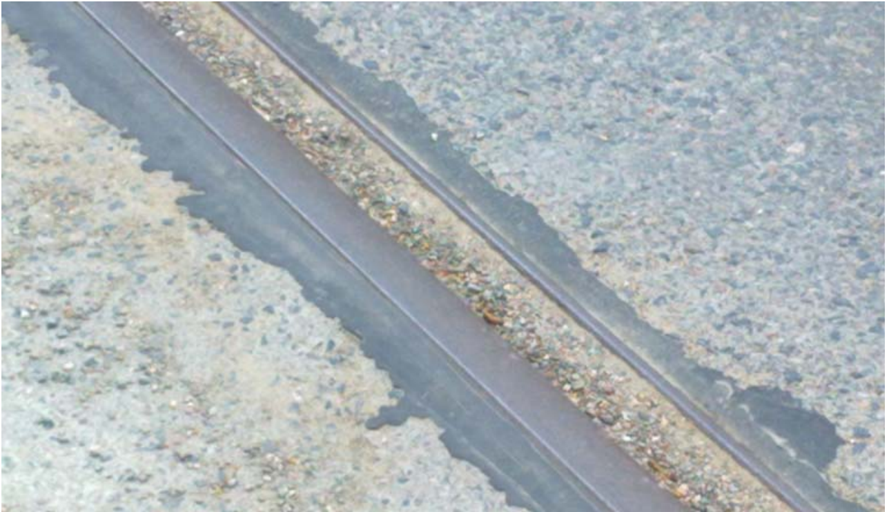
Kuva 3. Urakiskoraide täyttynyt hiekalla.
