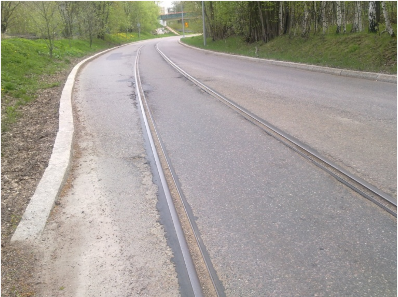
Kuva.2. Metron huoltoraide yleisen liikenteen kadulla.
