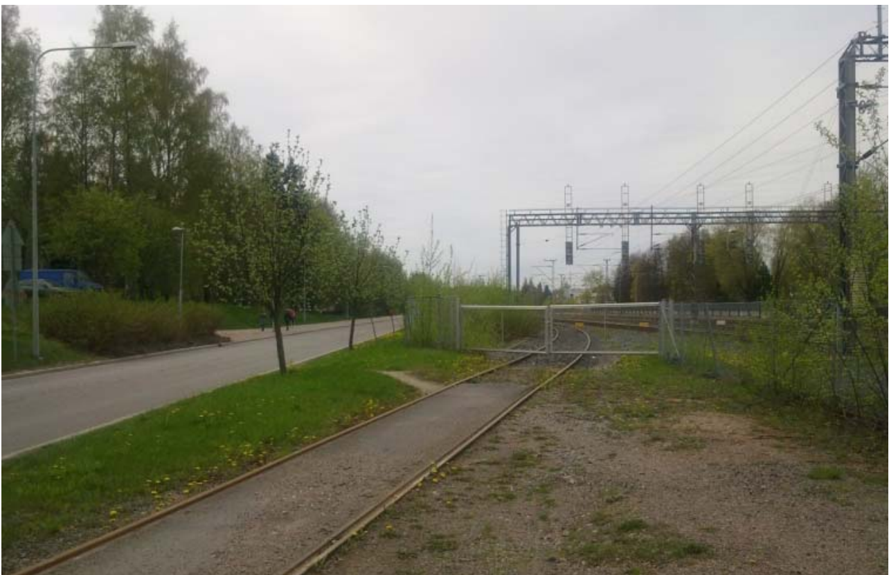
Kuva 6. Metron huoltoraiteen erkaneminen pääraiteesta (lukittu portti).
